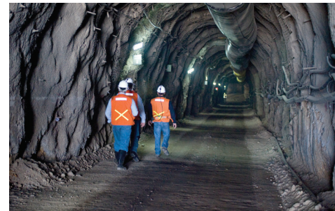
Los trabajadores caminan seguros por la mina de Cerro Negro con pernos de roca fortificando el túnel.
