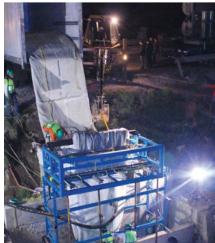
La instalación CIPP debajo de la carretera México-Tuxpan ayudó a asegurar que no hubiera interrupciones en la ajetreada autopista entre la capital del país y un importante puerto.
